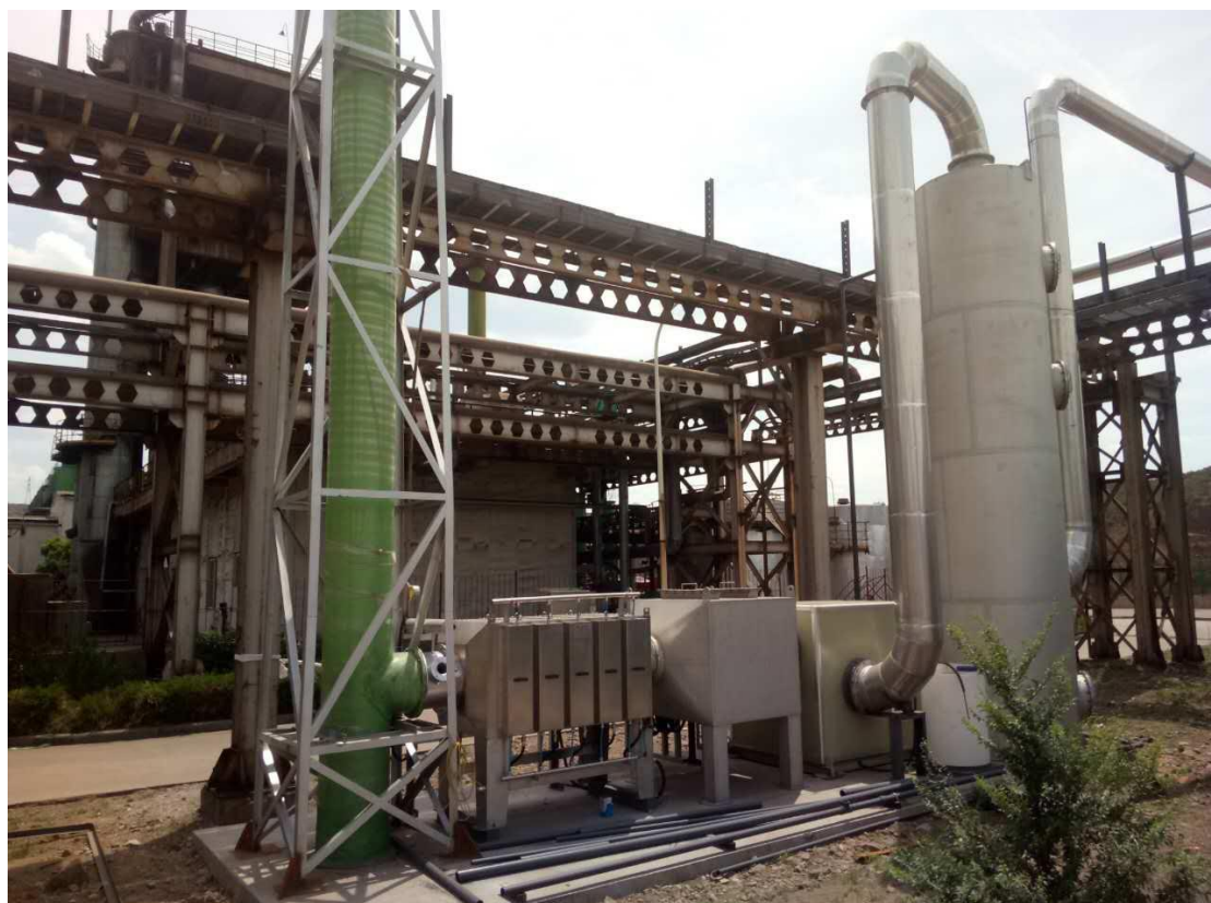
(1) 喷淋塔+药剂法：宜兴市华瑞水工业设备有限公司（工地河北）防爆型除臭设备
