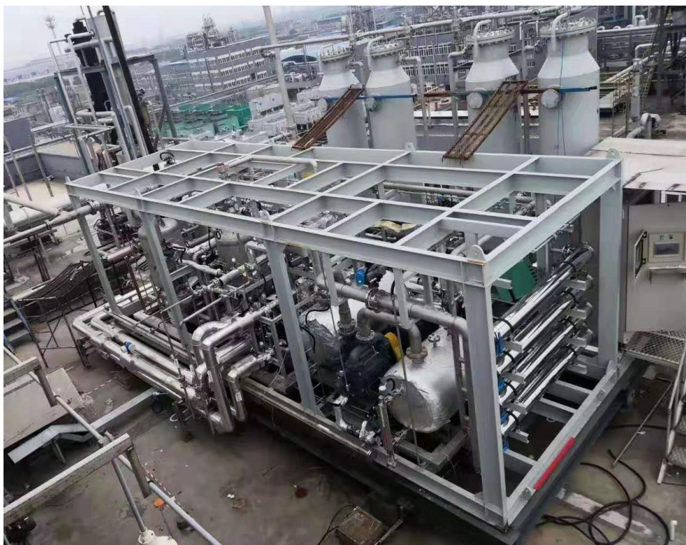
(1) 喷淋塔+药剂法：宜兴市华瑞水工业设备有限公司（工地河北）防爆型除臭设备
